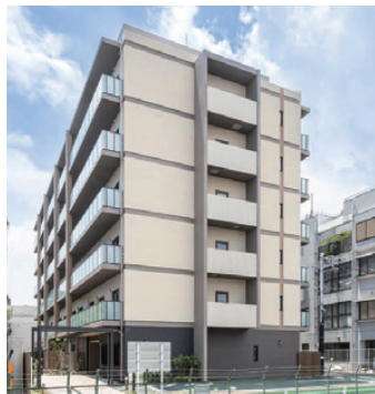
ドーマー大森町 80室 2025年10月開業
