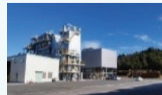
福島平田村バイオマスパワー [出力: 約4千kW]
