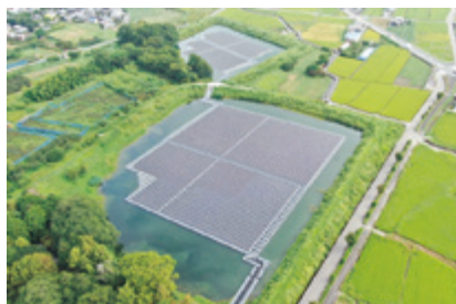
オフサイトPPAのスキームで脱炭素電力販売を実施中の照井池・大明神池水上太陽光発電所（愛媛県西条市）
