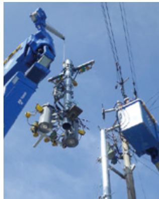
事前に機材を組み立てて設置することで柱上作業の効率化を図るブレハブ工法
