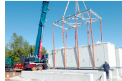
「北海道札幌蓄電所 系統用蓄電システム設置工事」での工事の様子
