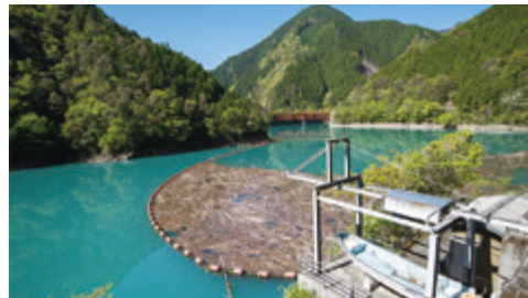
ダムに集まった流木は、収集して引き上げた後、住宅用建材や家具の材料などに利用（小見野々ダム）
