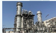
ハムリヤガス火力 (UAE) [出力: 約180万kW]
