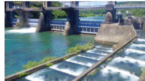
魚道の設置例：佐賀取水堰（佐賀発電所）
