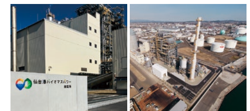
仙台港バイオマスパワー発電所
