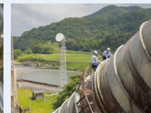
発電設備の巡視・点検
