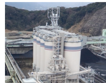
敦賀火力発電所2号機 バイオマス燃料貯蔵サイロ・運搬設備
