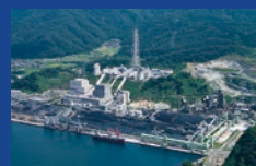
敦賀火力発電所1号機
