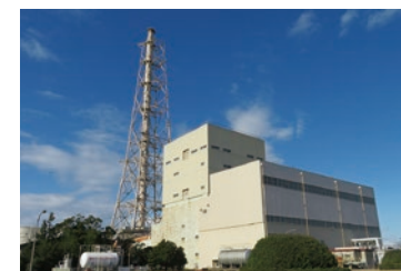
福井火力発電所
