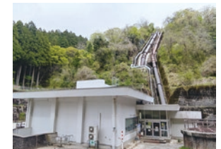
大日川第二発電所の全景
