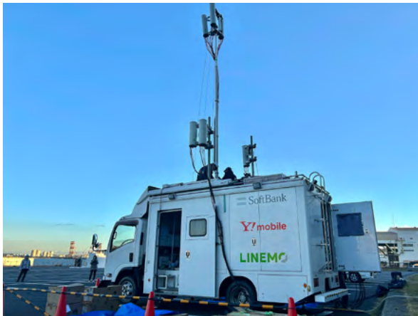
可搬型移動基地局
