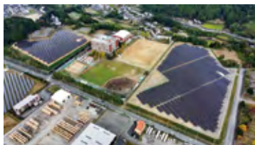
自社メガソーラー施設 (南海小峰台太陽光発電所)で発電した電力を「なんばパークス」および「なんばスカイオ」へ供給する自己託送を開始
