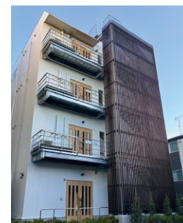
化学品研究所 (北区) (東武谷内田建設)
