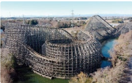
電力を供給される東武動物公園
