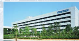
総合研究所竣工 (1986年)
