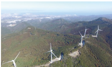
V-PPAにおける風力発電設備 大分ウィンドファーム外観
