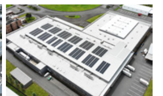
(株)SANKYO 三和工場屋根上 太陽光発電設備 撮影：株式会社サニックスエンジニアリングさま
