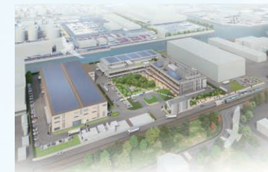
新本社・川崎製作所の外観図（イメージ）
