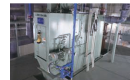
納入した回転式ドラムスクリーン「セルフクリーニングディスクスクリーン」
