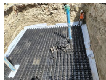
降雨を集める地下ピット建設の様子
