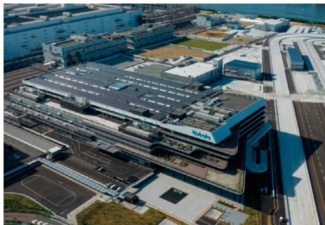
クボタグローバル技術研究所では出力1,566kWの太陽光パネルを設置
