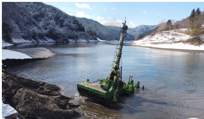
ダム の 浚 渫 作 業 を 行 う 水 陸 両 用 ブ ル ド ー ザ ー
