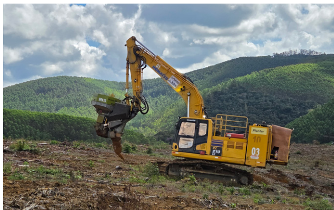
植林作業を行う油圧ショベル
