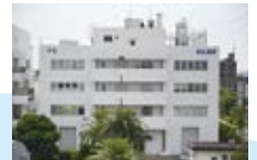
1986年 LRB採用、日本初の免震ビル オイルス工業本社(神奈川県)
