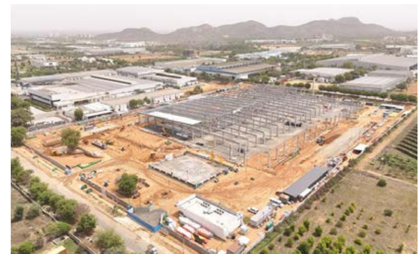
建設中のオイレスインド第2工場
