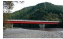
1991年 国内初のLRB免震橋梁 宮川橋(静岡県)
