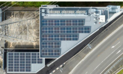
四日市事業所屋上のソーラーパネル
