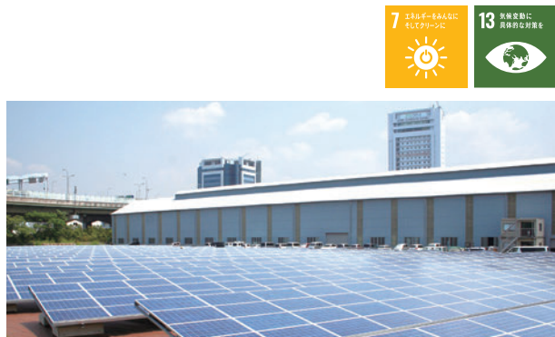
泉大津工場 太陽光発電設備
