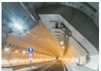
トンネルライト トンネルを火災から守ります。
