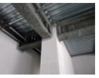
プロベストR-5 鉄骨を火災から守ります。
