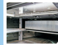
断熱工事 冷凍船を保冷します。
