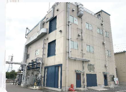
EUVフォトレジスト用ポリマー製造装置 α3 外観 (2022年完成)
