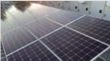
太陽光パネルの設置
