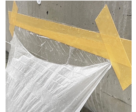
湿ったコンクリート面への一時固定・マーキング
