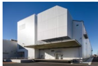
新原薬製造棟HB7 (2025年3月竣工)
