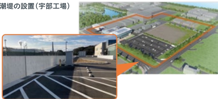
防潮堤の設置（宇部工場）
