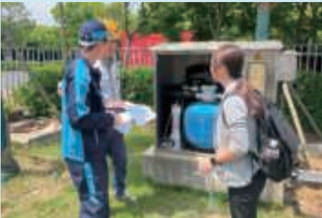
RMSZ第二工場における雨水再利用設備
