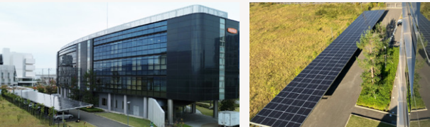
本社に設置したソーラーカーポート
