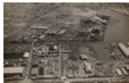
砂町第1・第2工場
