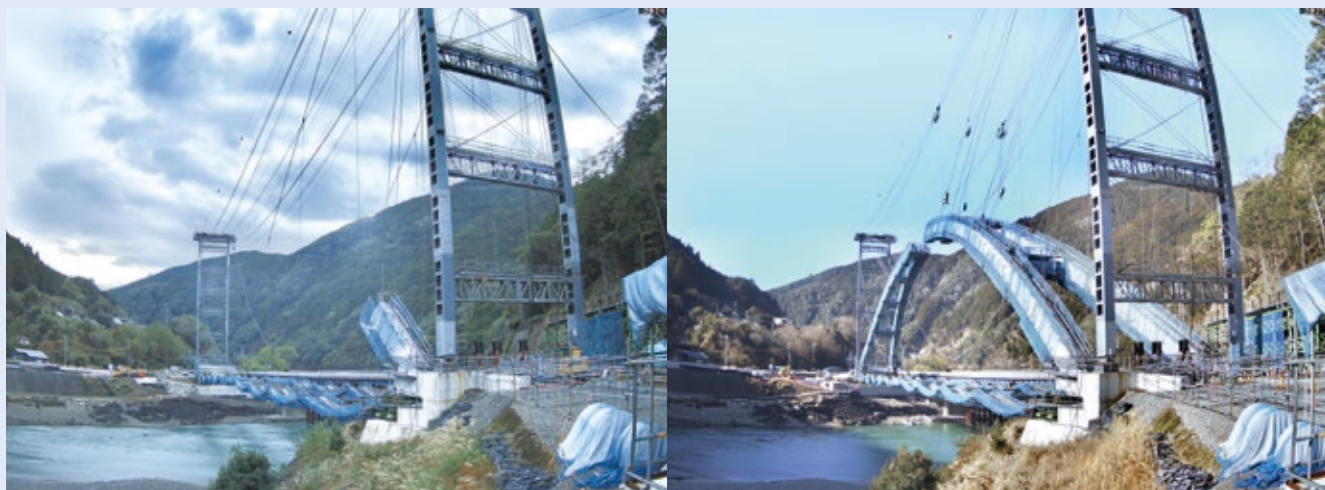
ケーブルクレーン斜吊り工法による鎌瀬橋アーチ桁架設の様子
