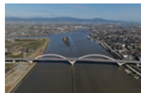
有明筑後川大橋
