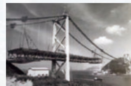
架設中の関門橋
