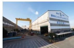
宮地エンジニアリング(株)千葉工場
