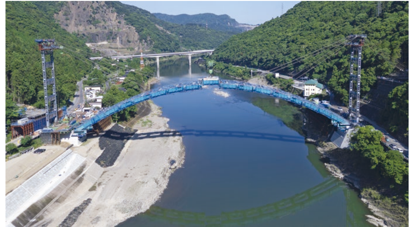
深水橋のアーチ桁閉合の様子
