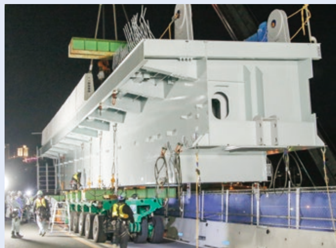
自走多軸台車上に桁を搭載する様子
