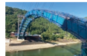
県道小鶴原女木線災害復旧深水橋上部工事
