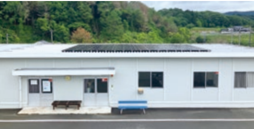
広島機材センターへ太陽光パネル設置
