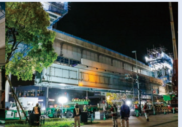
ダブルツインジャッキによる桁一括吊上作業の様子
