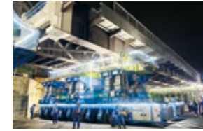
京都市・千里線淡路駅周辺連続立体交差工事(第5工区)
