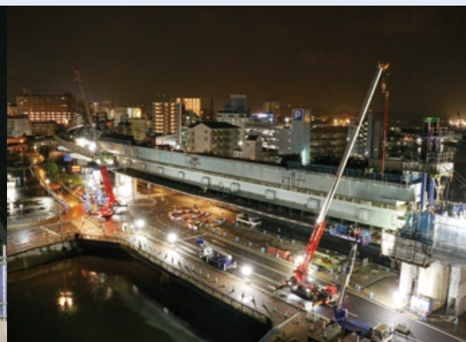
降下設備による桁一括降下作業の様子
