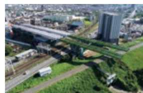
京阪電鉄 淀川東高架橋/鹿島建設株式会社
