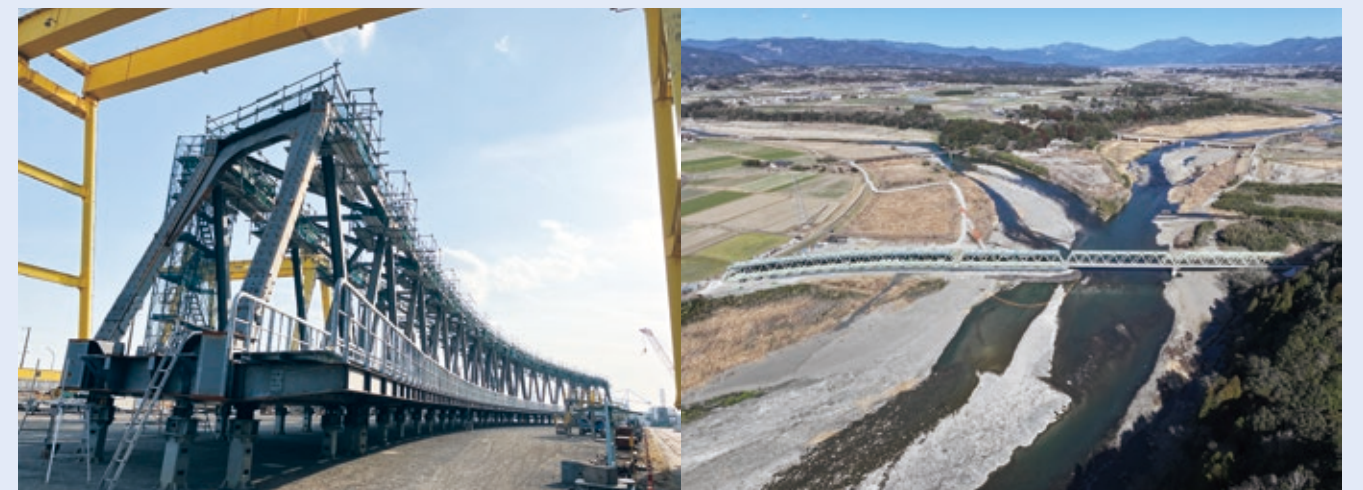
TT1橋梁の千葉工場での仮組立検査の様子
