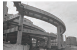
江戸橋ジャンクション（架設中）
