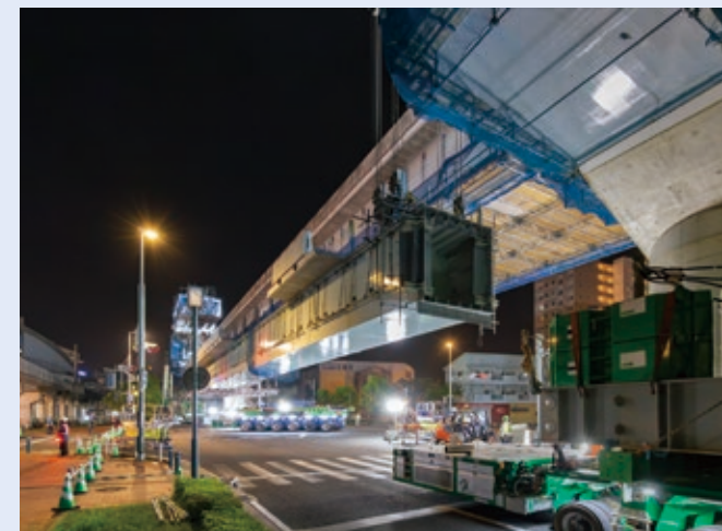
ダブルツインジャッキによる桁一括吊上作業の様子
