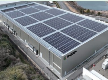
物流センターに設置された太陽光パネル
