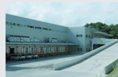
デュアルトラックバース (入出荷を複層化し効率性・安全性向上)
