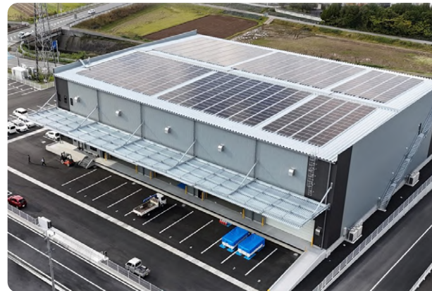
アルフレッサヘルスケア(株)九州物流センター 外観
