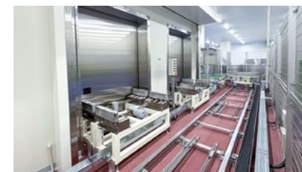
塩せき肉搬送・塩せき時間管理を自動化する自動ラック倉庫
