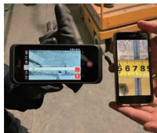
レーザー距離計を用いた 配管支持間隔の確認
