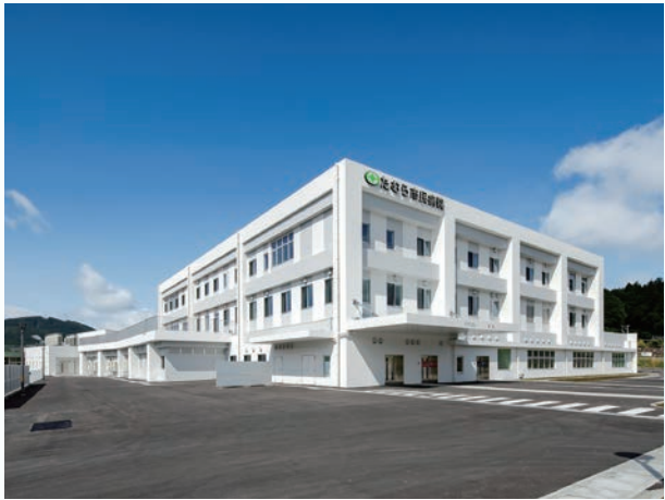
■ たむら市民病院 竣工年月: 2026年6月 所在地: 福島県田村市 建物用途: 病院
