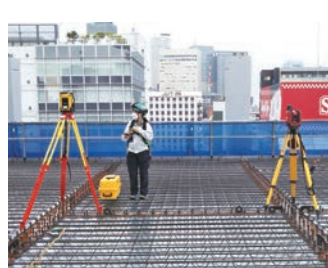
自動墨出しシステムによる レーザー墨出し
