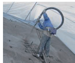
繊維補強モルタル吹付
