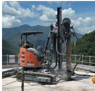
鉄塔基礎 施工状況 (SC-TEPドリル2号機)
