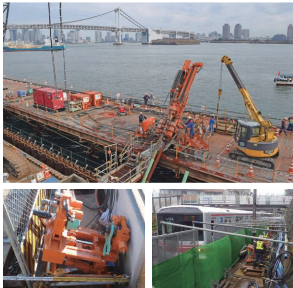
1.5mの幅があれば施工可能
