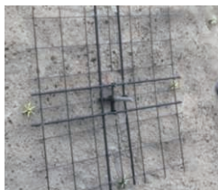
補強部材設置
