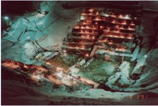
上大須ダム基礎処理工事 1993年
