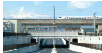
2008 東北本線南福島・福島間 太平寺ご道橋 (HEP&JES工法・COMPASS工法 (歩道部) 併用)
