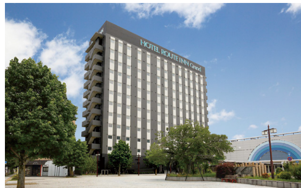
ホテルの施工例
