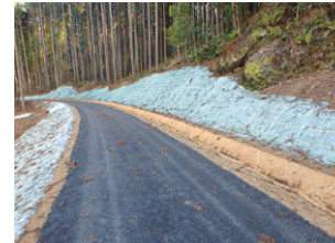
自然再生型法面植生工
