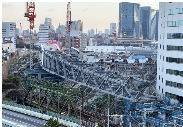
ハツ山橋りょう架け替え トラス橋送り出し
