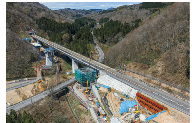
鉄道と道路の交差部の施工例
