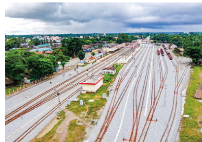
ヤンゴン・マンダレー鉄道整備事業 フェーズ1 CP102(ミャンマー)
