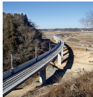
2013 東日本大震災復旧 JR仙石線野蒜工区
