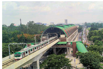
ダッカ都市鉄道6号線 橋梁および高架駅建設工事 CP-5(バングラデシュ)
