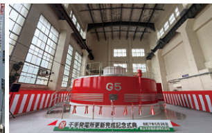
JR東日本信濃川発電所（千手発電所）の設備更新工事
