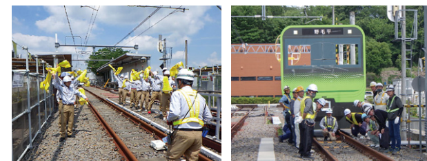
建設技術総合センター内に設置された複線軌道での安全教育
