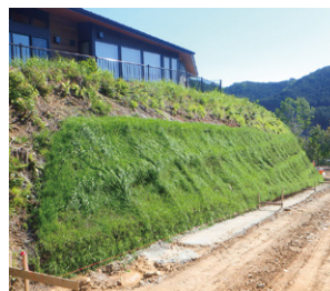
自然再生型植生法枠工
