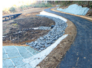
植生復元型排水自然土留め
