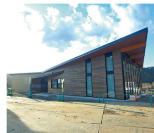
県材を活用した受付棟
