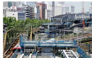
JR線等10線をまたぐ京急本線品川・北品川間 ハツ山橋りょう架け替え（撮影協力：JR東日本）
