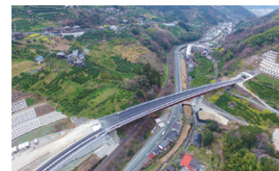
2023 予讃線伊予平野・千丈間 郷こ線橋新設工事
