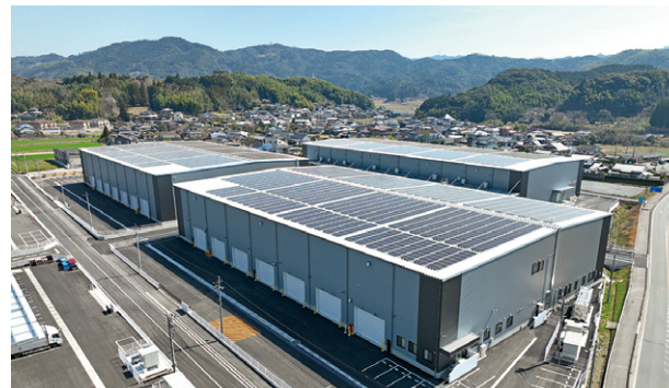
物流施設の施工例
