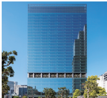
赤坂グリーンクロス新築工事(東京都)
