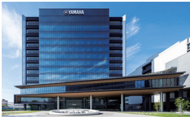
ヤマハ本社 2 2 号館新築工事(静岡県)
