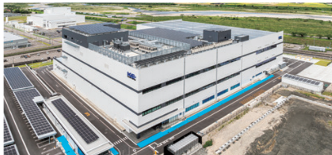
株式会社KOKUSAI ELECTRIC砺波事業所新築工事(富山県)
