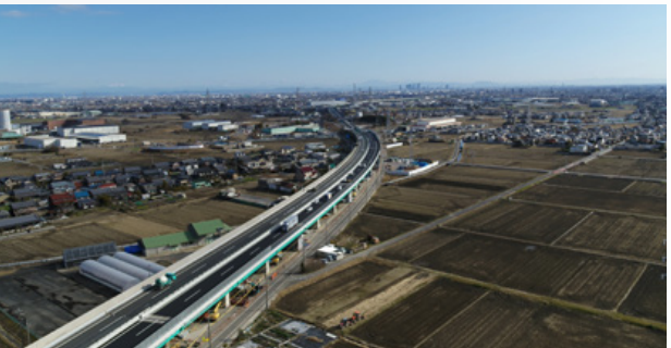
東名阪自動車道 弥富高架橋（下り線）（愛知県）
