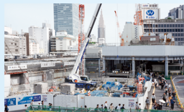
上／現場は壁を隔てて小田急線と京王線が隣接する。下／多くの歩行者が行き交う仮設の駅入り口。動線変更の際には、利用者への告知も徹底している
