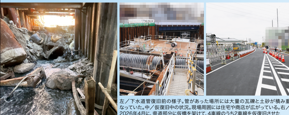
2025年10月時点の現場の様子。復旧工事は被災者救出や下水道管復旧、県道復旧など4つのフェーズに分けて行われた
