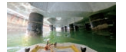
橋脚下の撮影
