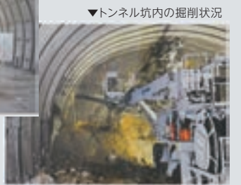
▼トンネル坑内の掘削状況
