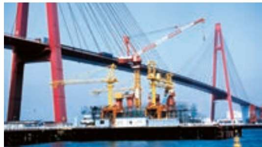
名港西大橋下部工
