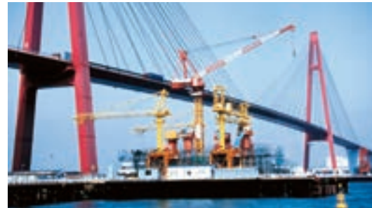
名港西大橋下部工
