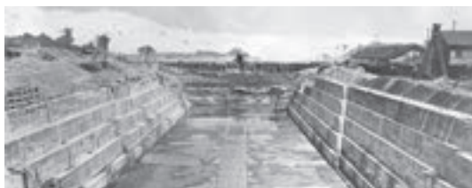
函館船渠室蘭ドック築造
