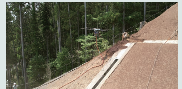
法面に吹付作業をおこなうドローン
