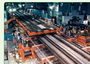
1991 東急池上線立体交差工事「STRUM工法」
