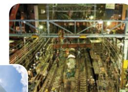
東急東横線渋谷～代官山駅間地下化事業
