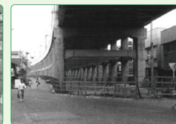
1966 東横線中目黒～都立大学間 立体交差工事(東急トラベラー工法)
