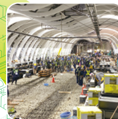
東京メトロ銀座線 渋谷駅移設工事
