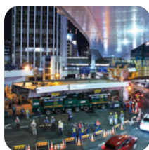
国道246号渋谷駅東口 歩道橋架替工事
