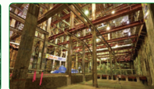
2011～2022 渋谷駅東口基盤整備工事
