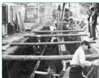
1960 渋谷川幹線下水工事
