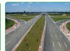
2014 ニヤットタン橋(日越友好橋) 建設工事その3
