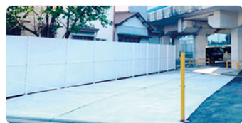
施工完了後の状況
