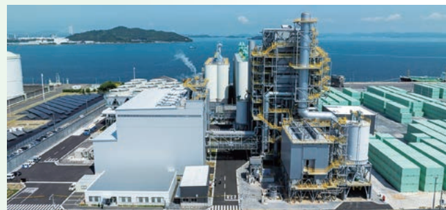
坂出バイオマス発電所
