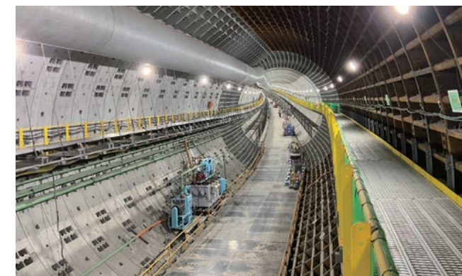
シールドトンネル工事の様子
